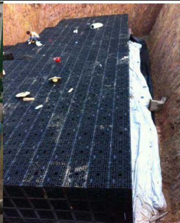
蓄水模块建设（示例）
