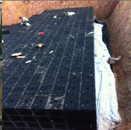
蓄水模块建设（示例）
